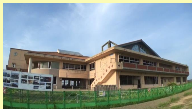
震災遺構として保存される旧中浜小学校舎。三角屋根の倉庫に避難した児童の足元まで浸水した(山元町)
