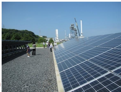
～電源開発㈱のメガソーラー発電～
