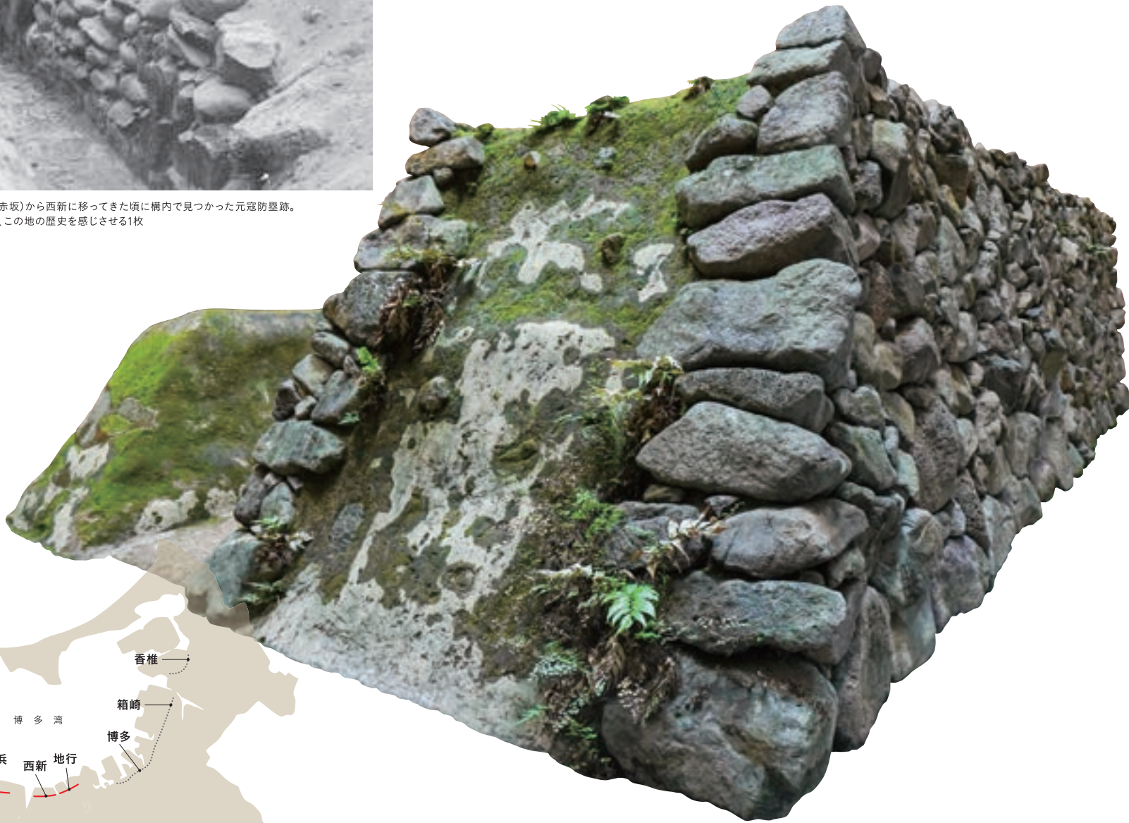
2.4mの本体の両面を石積みで堅固に整え、中に粘土と砂を交互に詰めて造られた防塁は歴史上初の出土であった
