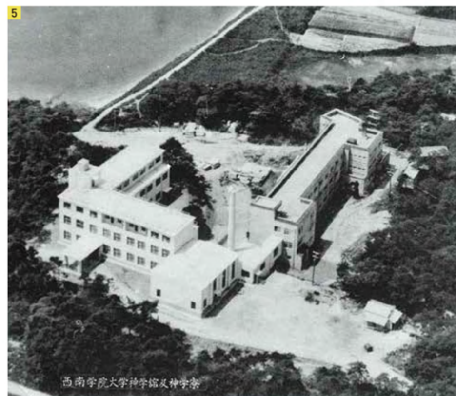
干隈神学部校舎(1955年竣工)
